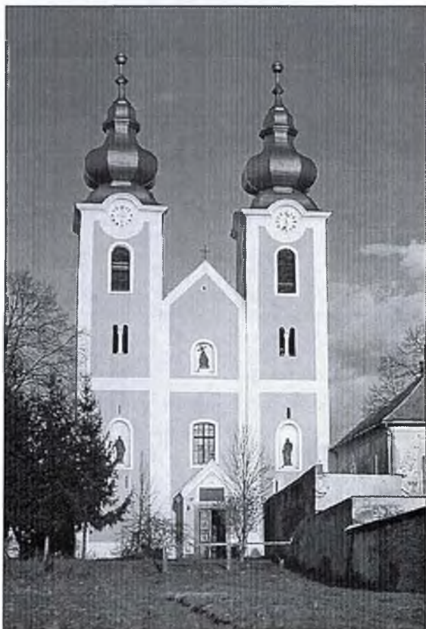
A kapornaki apátsági templom Ny-i homlokzata
